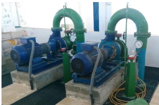
Figura 14 - Estação sobreprensa
