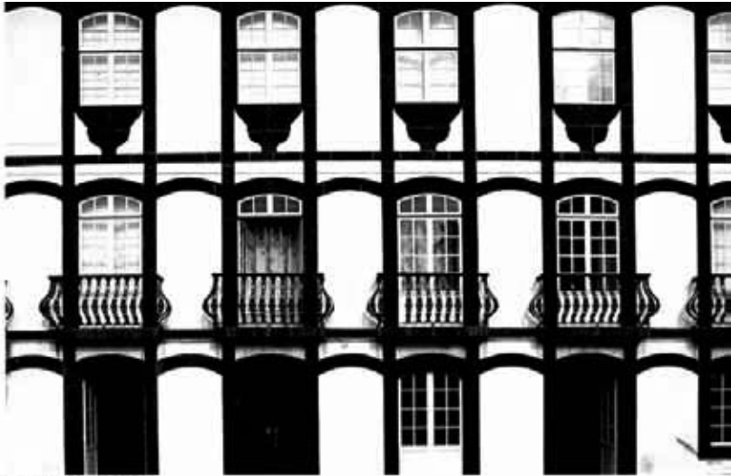
Fachada de casa de Francisco Barcelos.
