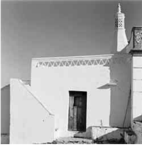
Figure 7. Inquérito à Arquitectura Regional Portuguesa. 'House with açoteia,' Corte da Seda (Alcoutim), 1955 (© Arquivo Ordem dos Arquitectos – IARP/OAPIX)
