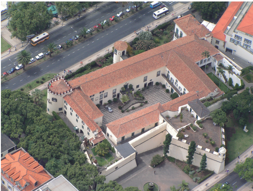
Figura 11 – Fotografia aérea do Palácio de São Lourenço Fonte: Arquivo do Museu Militar da Madeira
