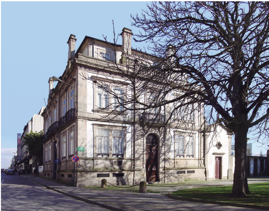
Figura 9 – Fotografia do edifício principal do Museu Militar do Porto
