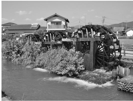
(写真7) 朝倉三連水車（福岡県朝倉町）
