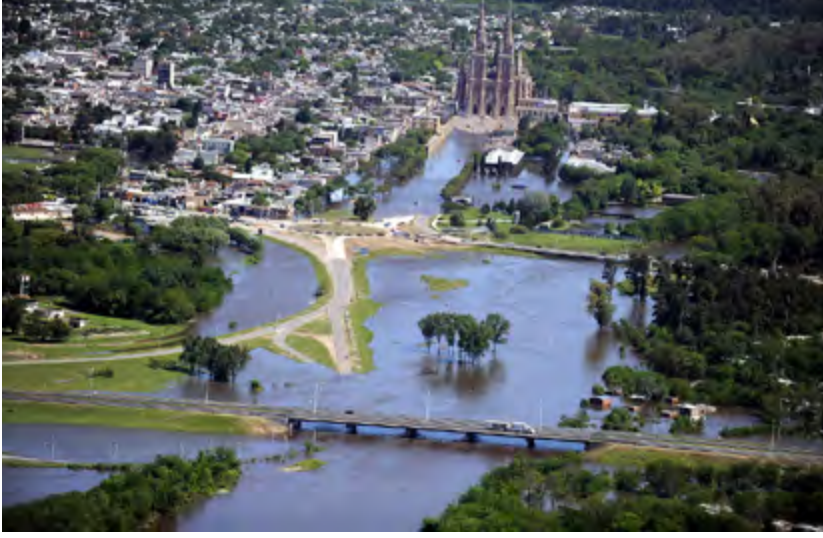
Vista de parte de la ciudad de Luján inundada
