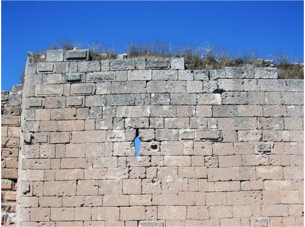
Figura 8. Ricostruzione del macro-periodo 4 di una porzione di cortina, da sud-est (foto: C. Tonghini)
