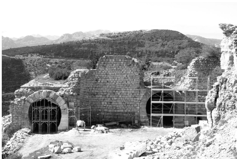
Fig. 1. Forte Campomolon, Vicenza. Interventi di pulizia, ripristino e consolidamento.
