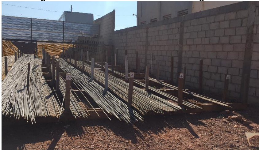
Figura 30 - Obra A: Armazenamento de vergalhões
