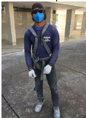
Figura 26 - Obra B: Funcionário portando EPI incompleto
