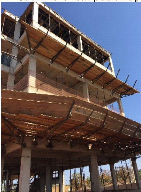
Figura 17 - Obra A: Torre 1 com plataforma principal
