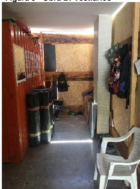
Figura 9 - Obra B: Vestiários
