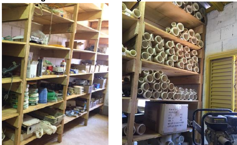
Figura 32 - Obra A: Estocagem dos materiais
