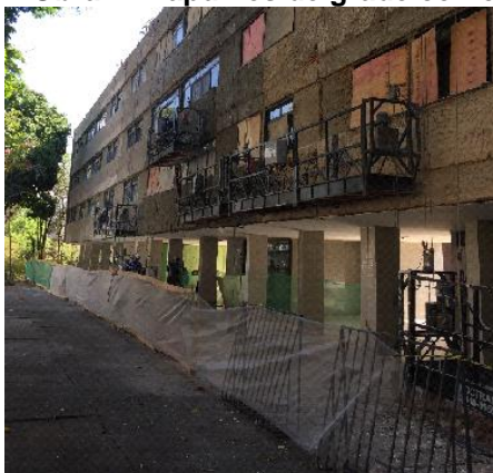
Figura 34 - Obra B: Tapumes de grade como proteção
