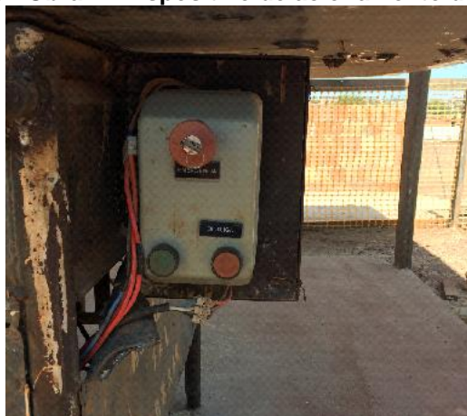
Figura 23 - Obra A: Dispositivo de acionamento da máquina
