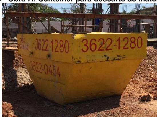
Figura 28 - Obra A: Contêiner para descarte de material
