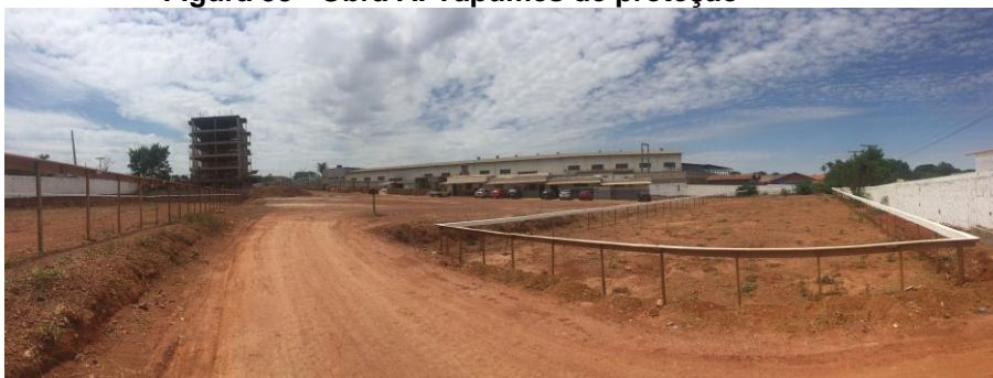
Figura 33 - Obra A: Tapumes de proteção
