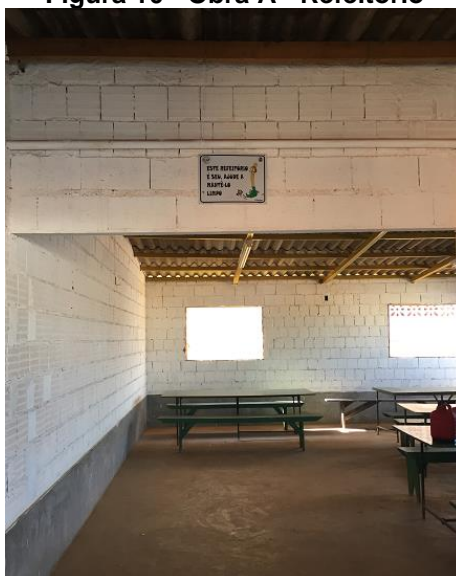
Figura 10 - Obra A - Refeitório
