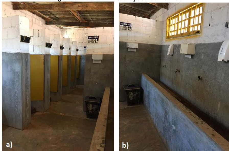
Figura 5 - Obra A: Instalações Sanitárias
