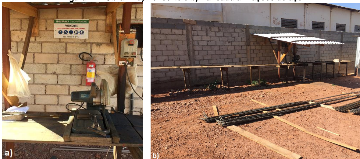
Figura 14 - Obra A: a) Policorte e b) Bancada armações de aço
