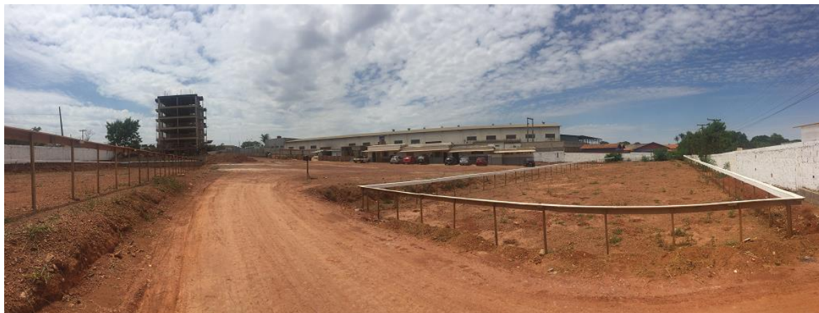
Figura 3 - Estágio que a obra se encontra
