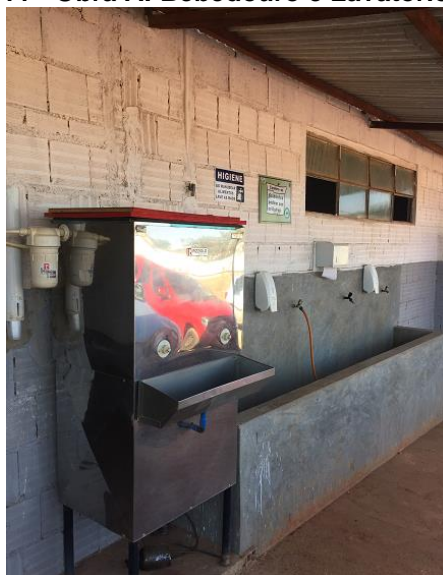
Figura 11 - Obra A: Bebedouro e Lavatório
