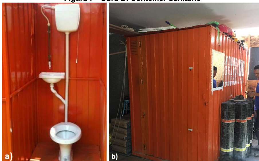
Figura 7 - Obra B: Contêiner Sanitário
