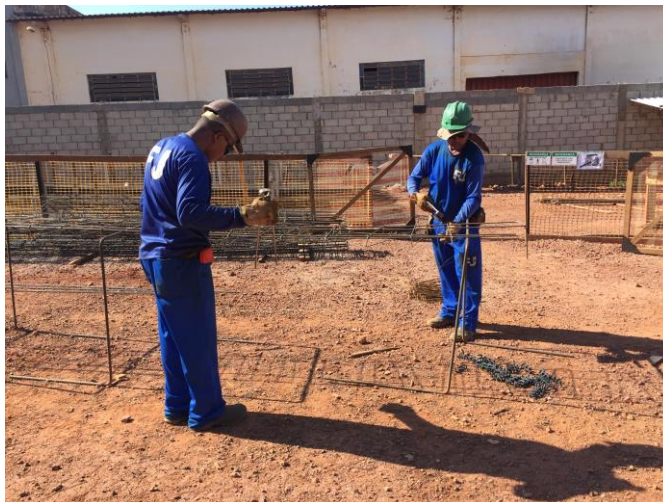
Figura 25 - Obra A: Funcionários com vestimenta e EPI adequados
