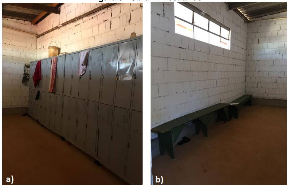
Figura 8 - Obra A: Vestiários
