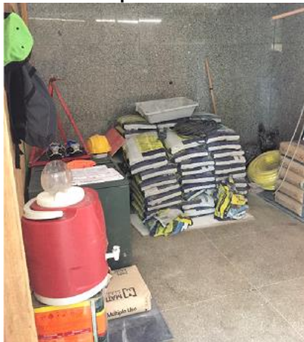
Figura 29 - Obra B: Local para armazenamento de materiais
