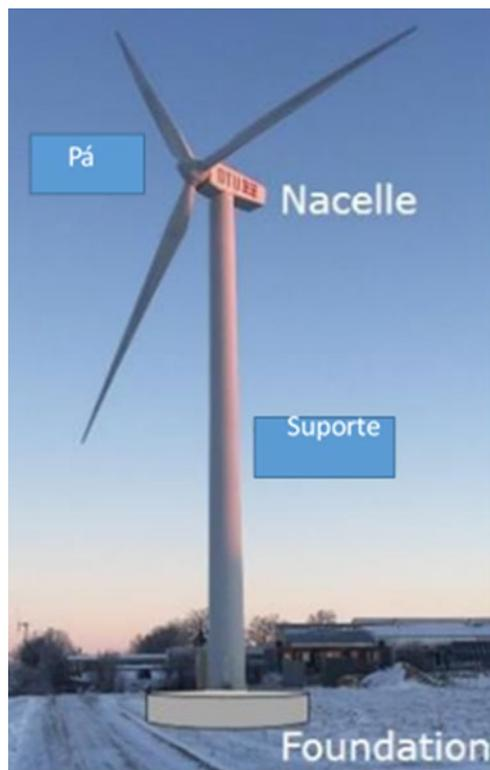
Figura 1. 3 Componentes básicos de uma turbina eólica adaptado de [11].
