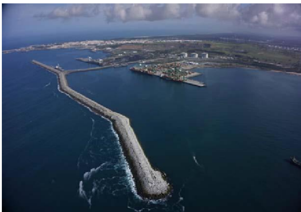
Figura 2.8 – Molhe leste após as obras da 2ª ampliação (Conduril, 2012)
