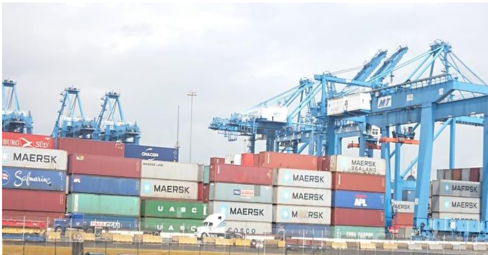
Figura 4. Grúa puerto Manzanillo.
