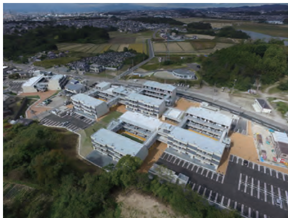
図9 上空から望む 七ヶ浜町菖蒲田浜地区災害公営住宅
