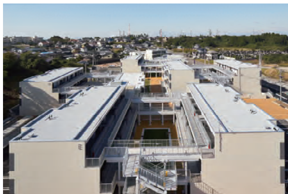
図10 七ヶ浜町菖蒲田浜地区災害公営住宅
