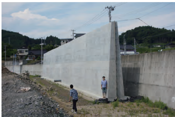
図 5 岩手県陸前高田市の防潮堤
