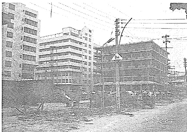
写真1 セクター18に建設中のショッピング・コンプレックス 1997年著者撮影
