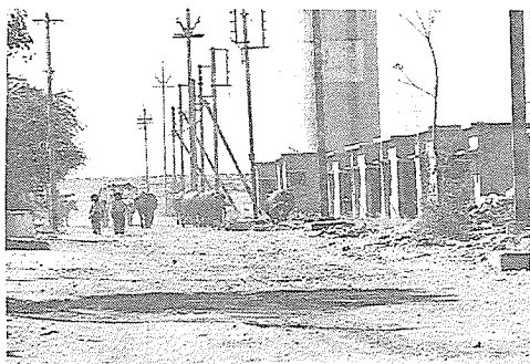
写真3 未舗装のメインストリートと建設中のBセクター (1996年11月)
