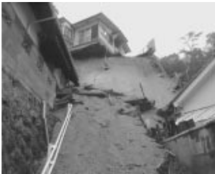
写真3 (右上) 国道432号沿い、棕梨川右岸側の斜面の崩落 (賀茂郡河内町、2001年3月25日)
