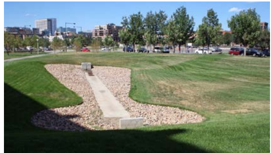
Bild 12. Tillfällig översvämningssyta. Foto: Jeffrey Beall 2010
