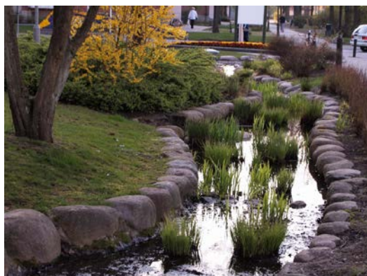
Bild 4. Dagvattenkanal. Foto: Christer 2012
