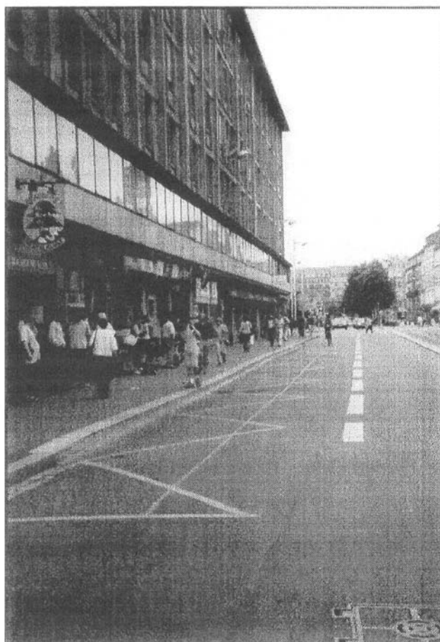
Arrêt Homme de Fer Quai de grande longueur (3 emplacements articulés) en centre ville (bordures de granite)
