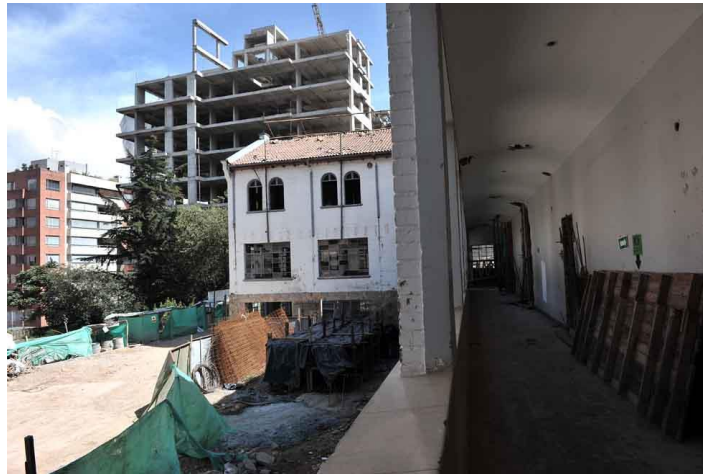
Ilustración 3. Colegio femenino Colsubsidio antes de intervención.
