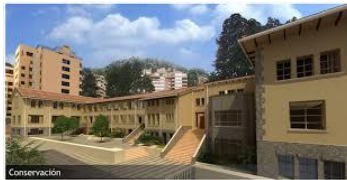
Ilustración 4. Colegio femenino Colsubsidio después de intervención.
