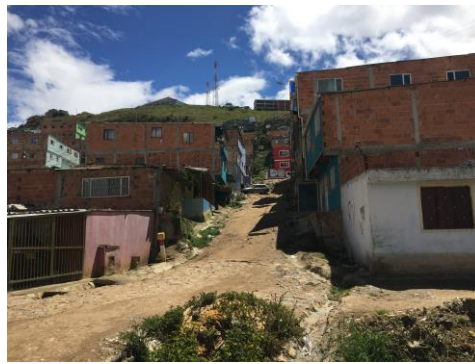
Figura 7- Estado de las vías.
