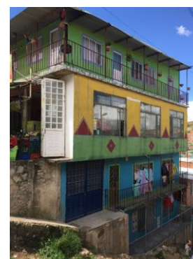
Figura 13- Imagen de vivienda progresiva y productiva del barrio Caracolí.
