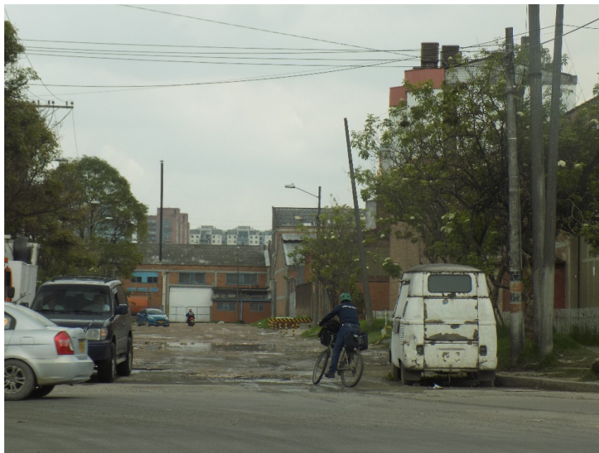
Imagen 8. Estado de eje vial en Puente Aranda
