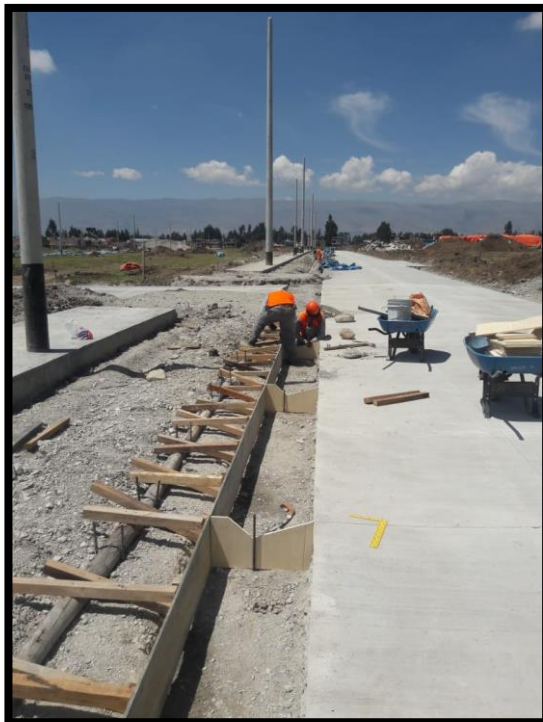
Foto.- Seguridad en Obra
