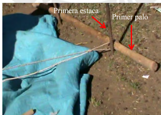
Figura 13. Coloca el palo con la lazada junto a una de las estacas.
