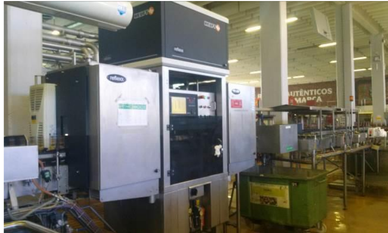
Figura 8 – Inspetor de garrafas vazias da linha 6
