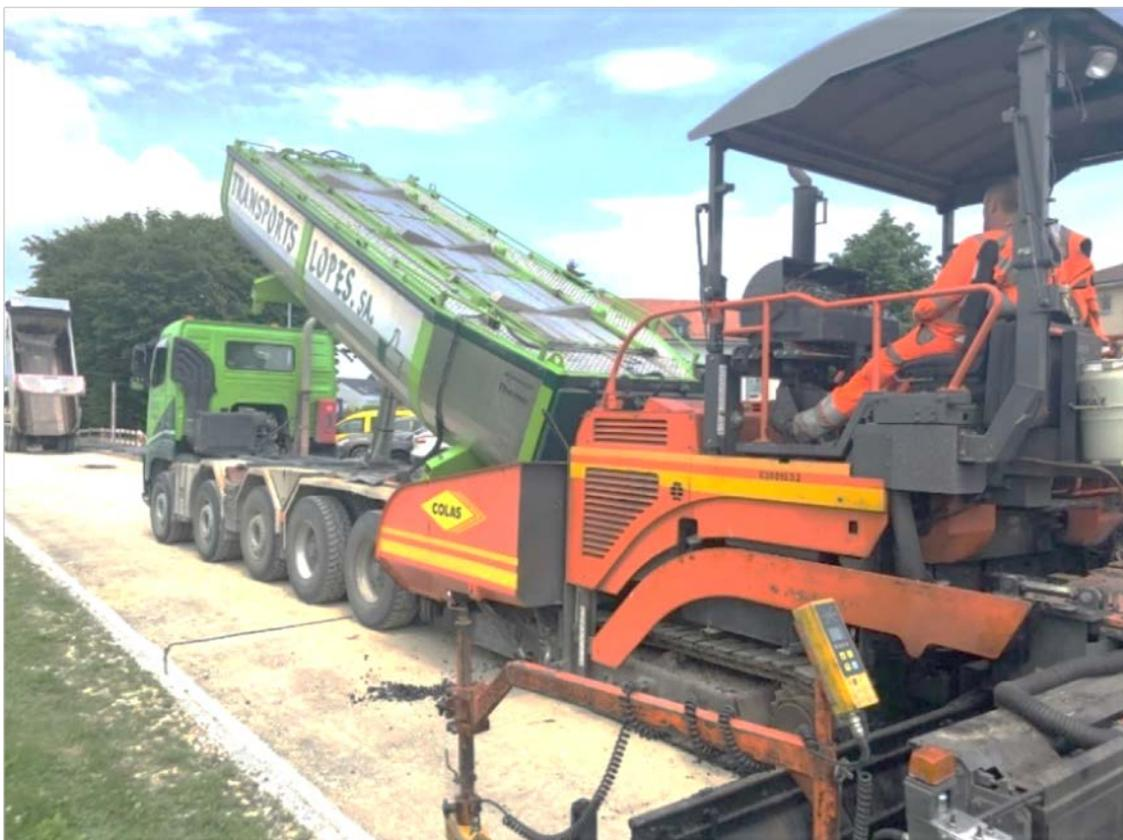
Figura 139 - Contentor a descarregar asfalto para máquina pavimentadora (vista traseira)
