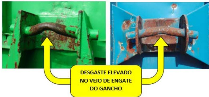
Figura 81 - Exemplos de desgaste elevado no veio de engate do gancho (autoria própria)
