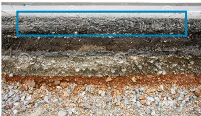
Figura 33 - Exemplo em corte de uma via rodoviária com asfalto (adaptado de [38])
