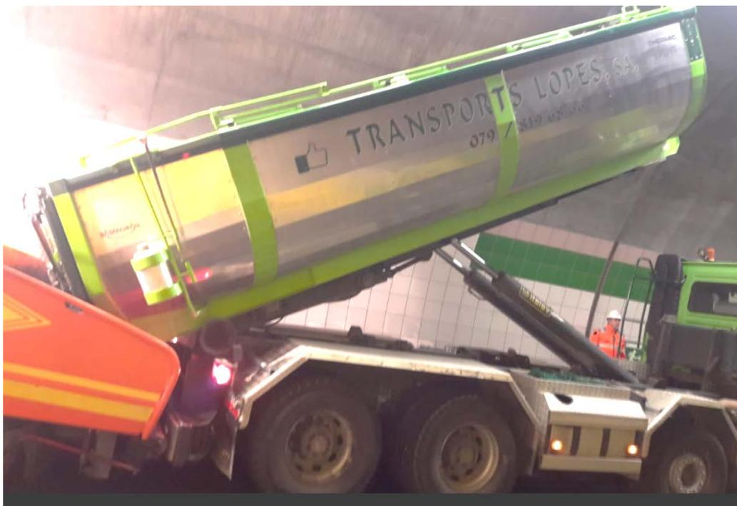
Figura 137 - Vista lateral do contendor em trabalho a descarregar asfalto para máquina pavimentadora (fotografia fornecida pelo cliente)
