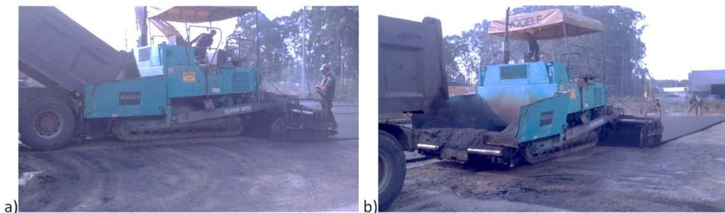
Figura 36 - a) Exemplo de uma descarga de asfalto para a máquina pavimentadora b) vista da máquina pavimentadora depois da descarga (autoria própria)
