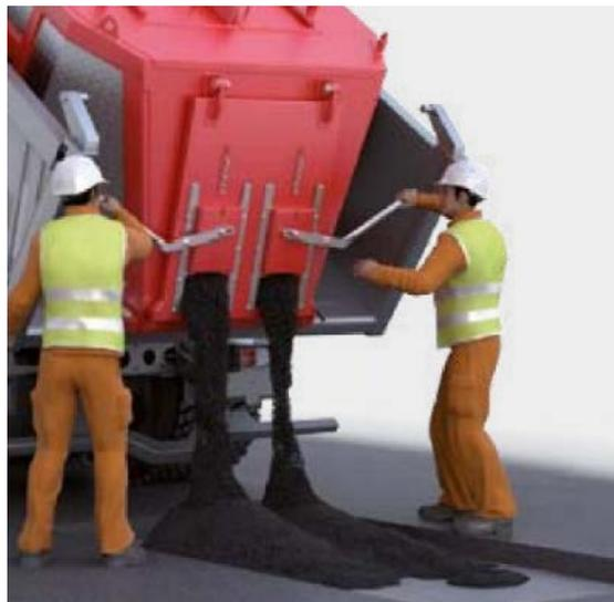
Figura 80 - Exemplo de descarregamento do asfalto através das portinholas manuais [44]
