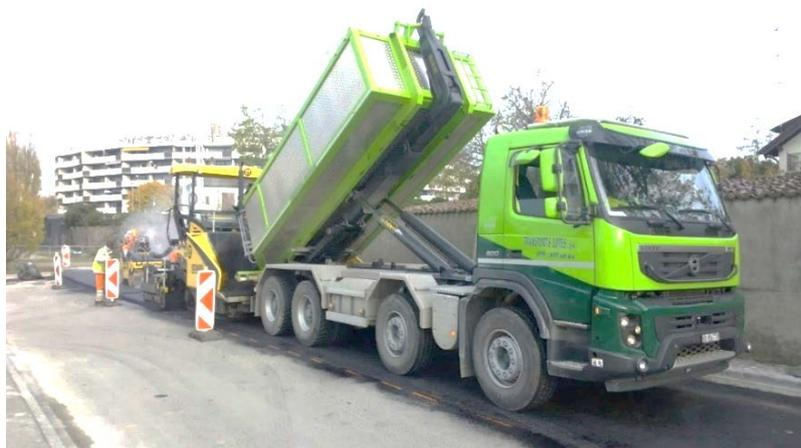
Figura 1 - Exemplo de descarga do asfalto para a máquina pavimentadora [5]
