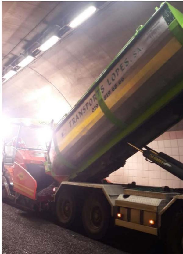
Figura 136 - Contendor em trabalho a descarregar asfalto para máquina pavimentadora dentro de um túnel - vista lateral frente (fotografia fornecida pelo cliente)
