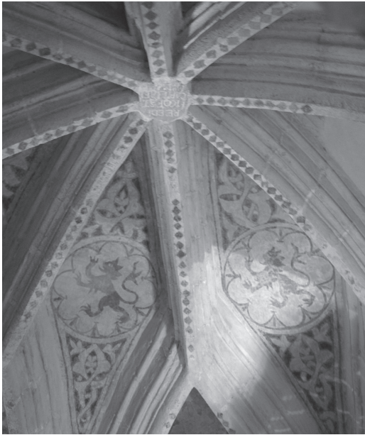
Figura 10 Detalle de la bóveda
