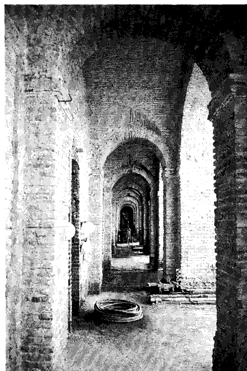
Figura 4 Vista general de la galería resuelta mediante sucesión de bóvedas ejecutadas a rosca. Cuartel de la Puerta de la Carne de Sevilla
