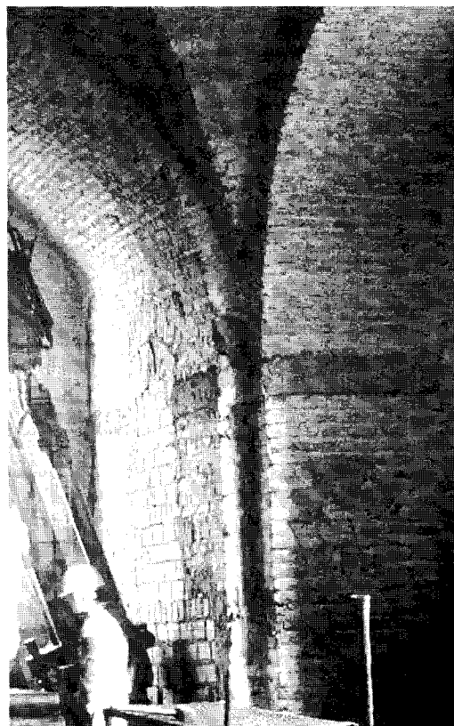
Figura 6 Detalle de bóvedas de arista en la planta baja del Cuartel de la Puerta de la Carne de Sevilla
