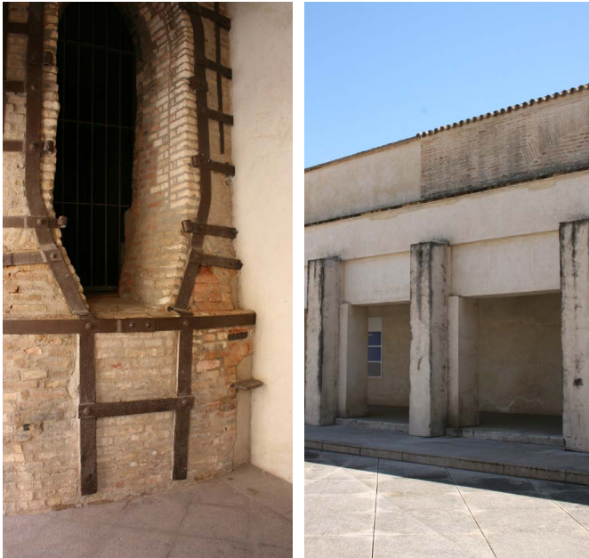
A la izquierda, chimenea "superpuesta" sobre la traza del claustro. A la derecha, recuperación del claustro. Proyecto de los hermanos Sierra | foto Marta García-Casasola
