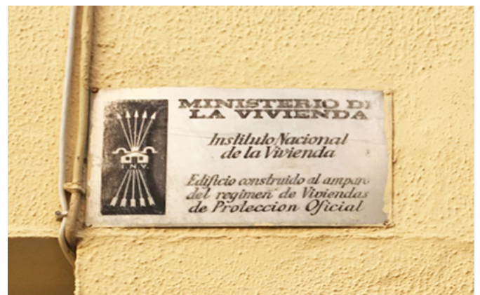
Placa del Instituto Nacional de la Vivienda. Grupo de Viviendas Ntra. Sra. de la Caridad (Sanlúcar de Barrameda, Cádiz) | foto Daniel Navas Carrillo (2018)
