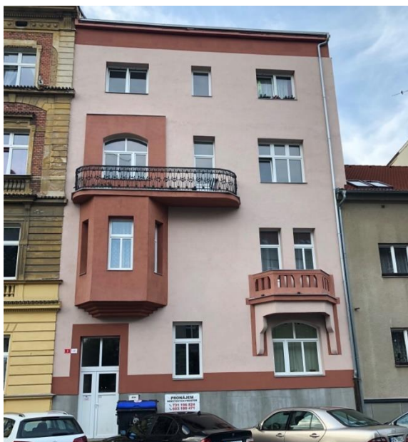
Obrázek 6 -Zrekonstruovaná nemovitost (foto z roku 2019)
