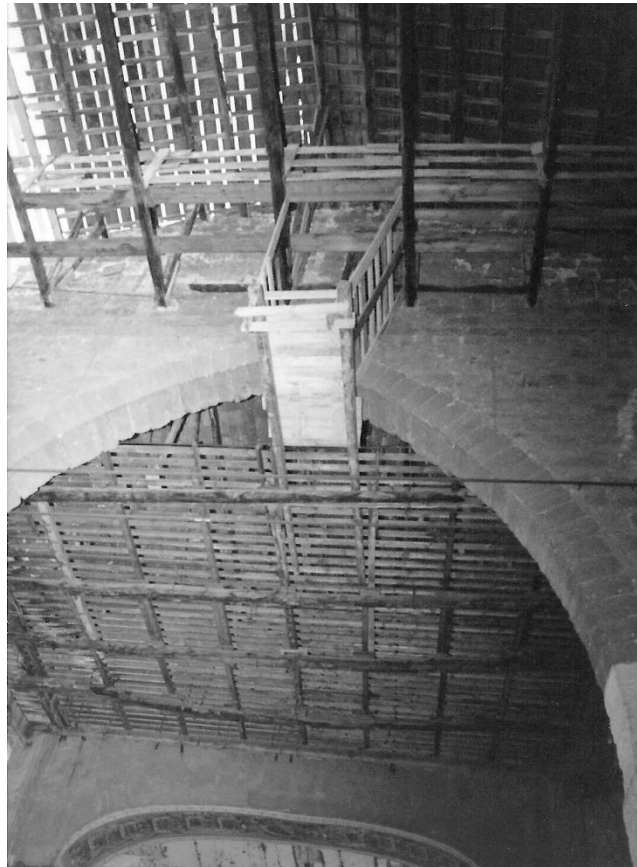
Figure 2.11 Garibaldi theatre in Palermo – the trellis on the stage Ref; Calogero Vinci, Il teatro Garibaldi a Palermo e la costruzione dei teatri storici minori , Palermo 2013, Edizione fotograf
