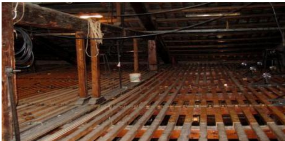
Figure 2.12 Graticcio trellis of the Pergolesi Theater - Jesi (Ancona). Ref; Calogero Vinci, Il teatro Garibaldi a Palermo e la costruzione dei teatri storici minori , Palermo 2013, Edizione fotograf.
