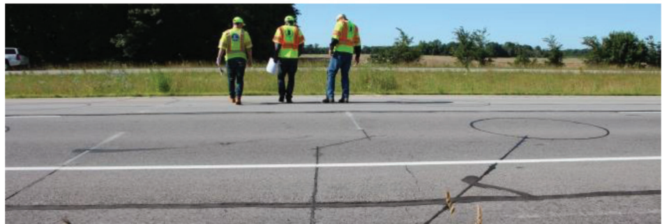
(d) WIM station #952100 pavement and sensor conditions
