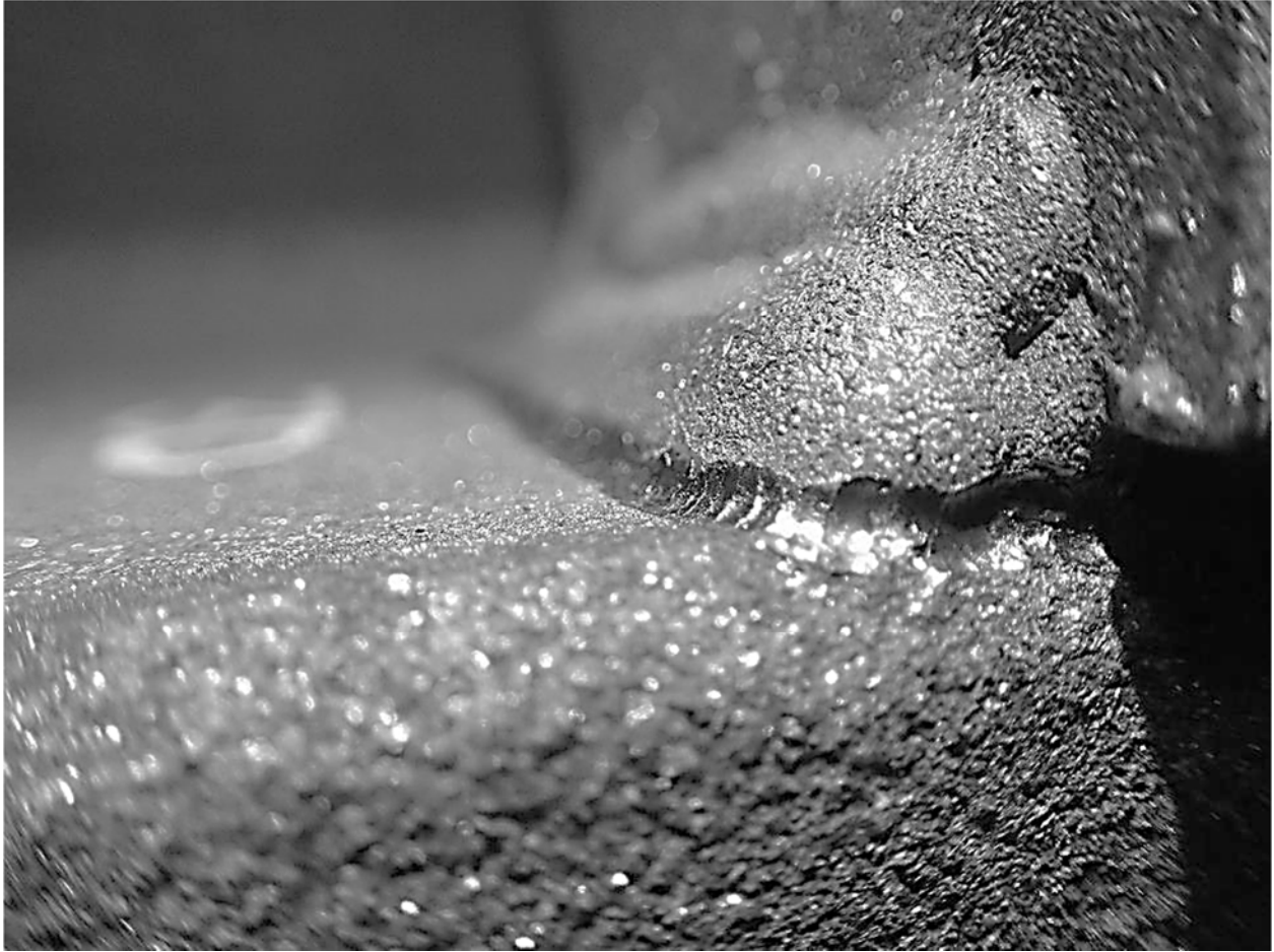
Figure 3.9: Profile of Transverse Stiffener Weld Toe After UIT
