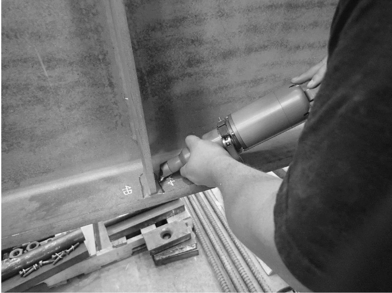
Figure 3.7: Application of UIT at Transverse Stiffener
