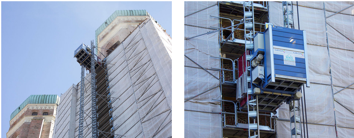
Bild 2.1: Renovierung der Frauenkirche und dazu verwendeter Zahnstangenaufzug [70]
