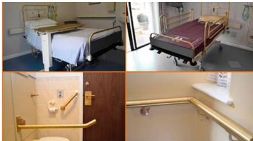
Figura 1.7. Instalaciones hospitalarias con cobre antimicrobiano 85
