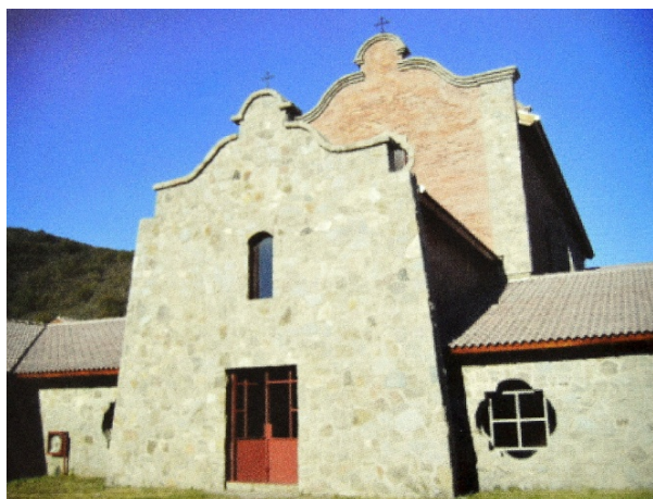
Fig. 8. Cartuja de San José. Vista de la iglesia conventual desde el claustro. 2005. (Foto Federico Shanahan)
