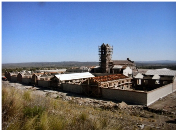
Fig. 13. La Cartuja de San José en construcción. 2003. (Foto Federico Shanahan)
