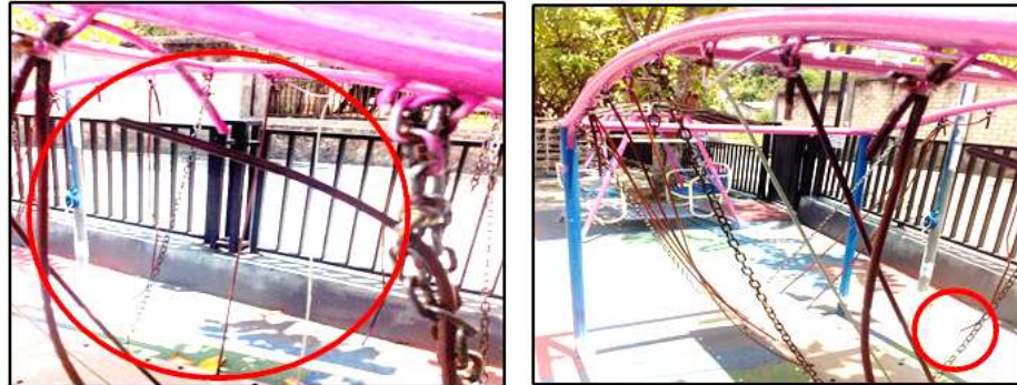
Gambar 5. Kawat pada Jembatan Gantung
