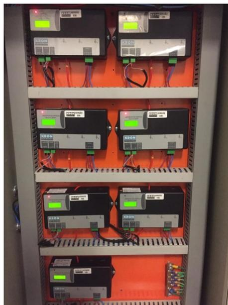
Figura 23 - Painel de medidores MULT K30
