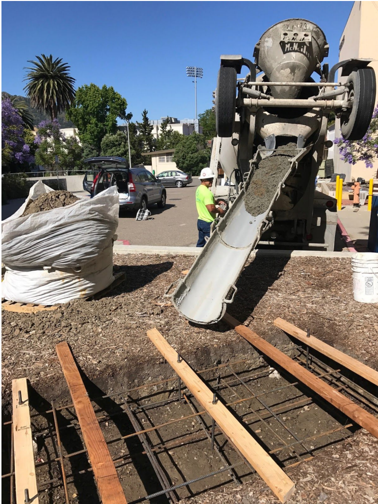
Figure 16: Concrete Pour
