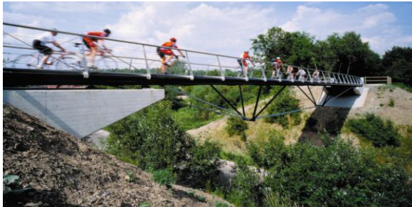
Jumet footbridge (courtesy of Jean Marie Cremer, Bureau Greisch)
