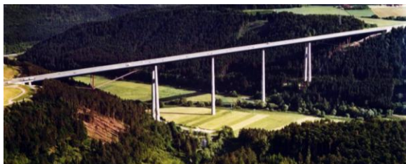
Figure 1. Weitingen viaduct (photograph courtesy of Holger Svensson, Leonhardt, Andra und Partner)
