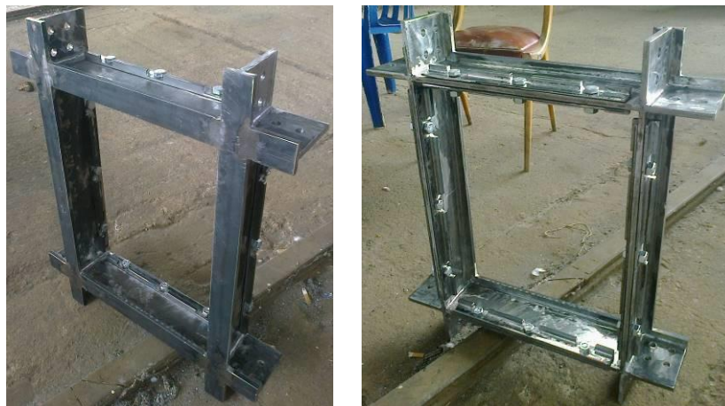
Слика 3. Челични оквири спремни за монтажу испуне од ламелираног стакла / клирита
