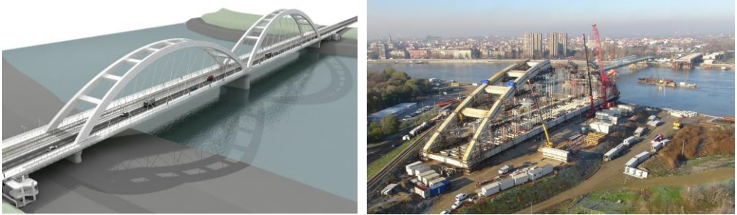
Slika 1 – Železničko-drumskog mosta u Novom Sadu: vizuelizacija i u izgradnji.
