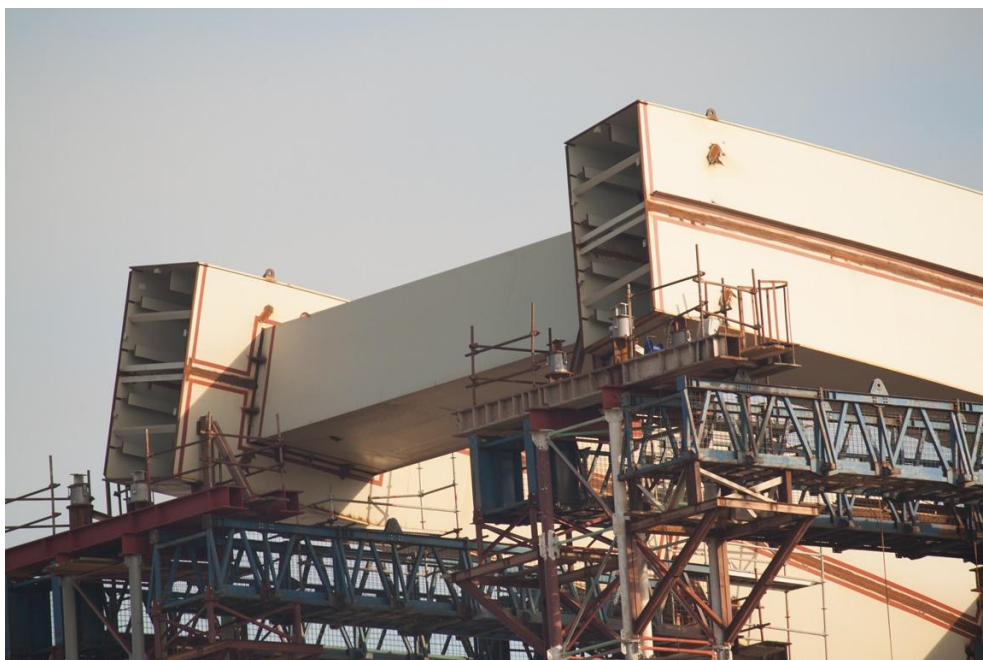
Slika 5 – Lukovi lučnog mosta raspona 177 m u montaži.
