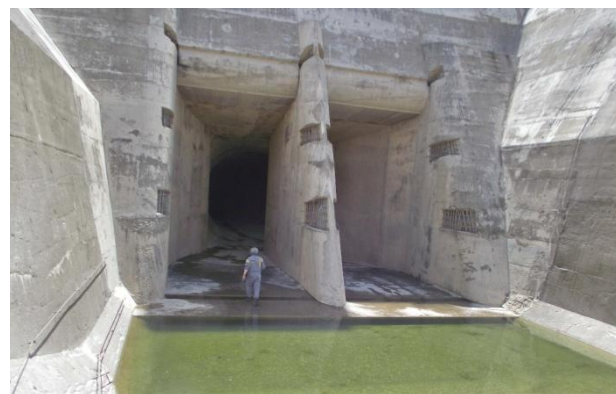
Slika 6. Ulaz u derivacioni tunel FPBA
