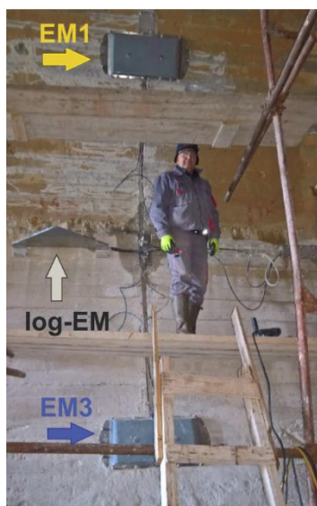
Slika 5. Prikaz dve ravne EM FLAT 700 sonde i jedne log-EM sonde na mernom mestu u tunelu FPBA
