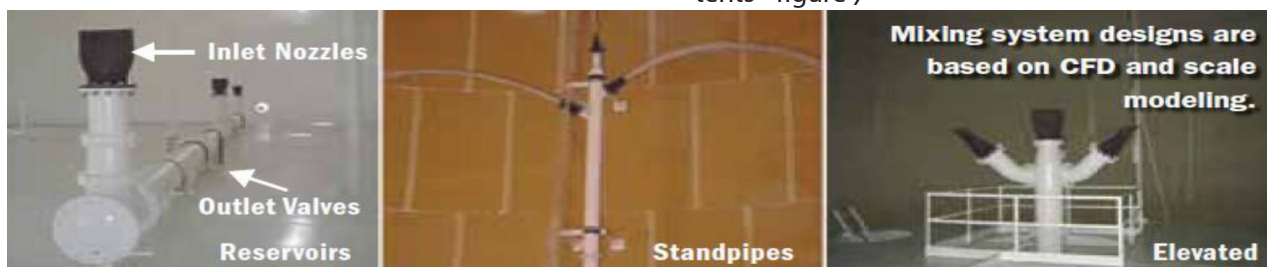
Slika 7. Primeri ugradnje opreme za pasivno ili aktivno mešanje
