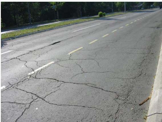
Слика 3. Блок пукотине и колотрази на десној страни коловоза пре рехабилитације (Тривић, 2005.)
