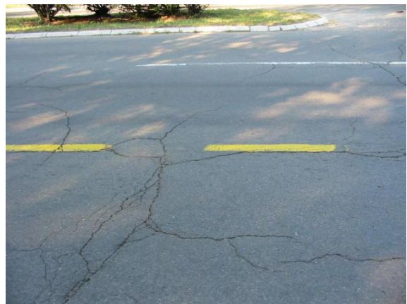
Слика 2. Попречне и блок пукотине на левој страни коловоза пре рехабилитације (Тривић, 2005.)
