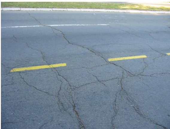
Слика 2. Попречне и блок пукотине на левој страни коловоза пре рехабилитације (Тривић, 2005.)
