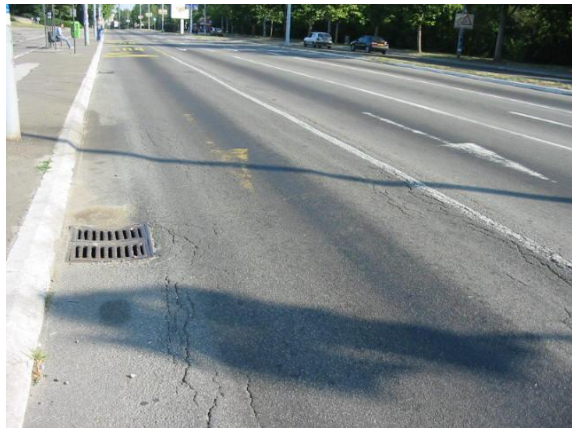
Слика 3. Блок пукотине и колотрази на десној страни коловоза пре рехабилитације (Тривић, 2005.)
