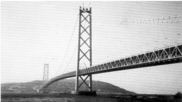
Slika 9. Izgled mosta Akashi–Kaikyo
