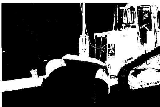
Slika 5. Brana Platanovrissy: sistem razastiranja i zbijanja
