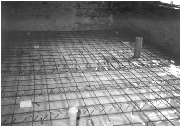
Slika 11. Izgled međuspratne konstrukcije na zgradi Glavne pošte u Arandelovcu neposredno pre betoniranja
