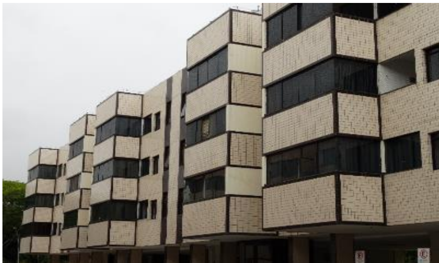
Figura 14 - Fachada Leste do edifício.
