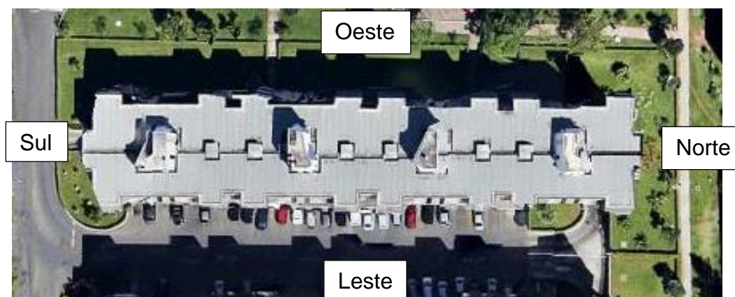
Figura 12 - Localização das fachadas Norte, Sul, Leste e Oeste do edifício.
