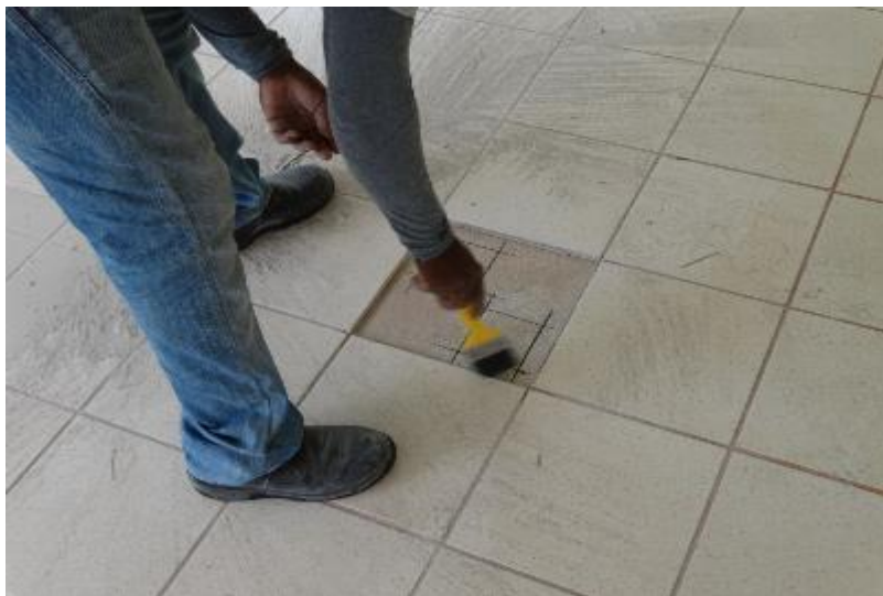
Figura 49 – Preparação para aplicação da cola sobre a pastilha metálica.
