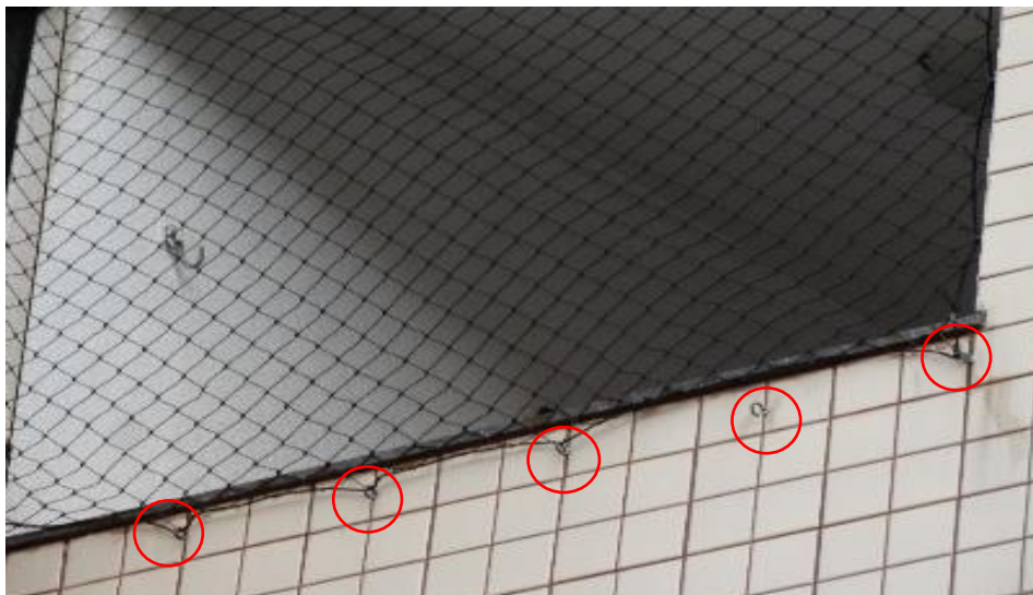
Figura 16 - Pontos de fixação das telas de proteção.
