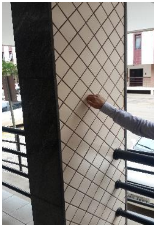
Figura 47 – Ensaio de Percussão nos Pilares.
