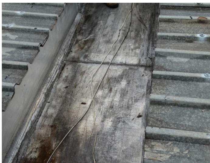
Figura 29 – Cobertura em Telha Metálica.
