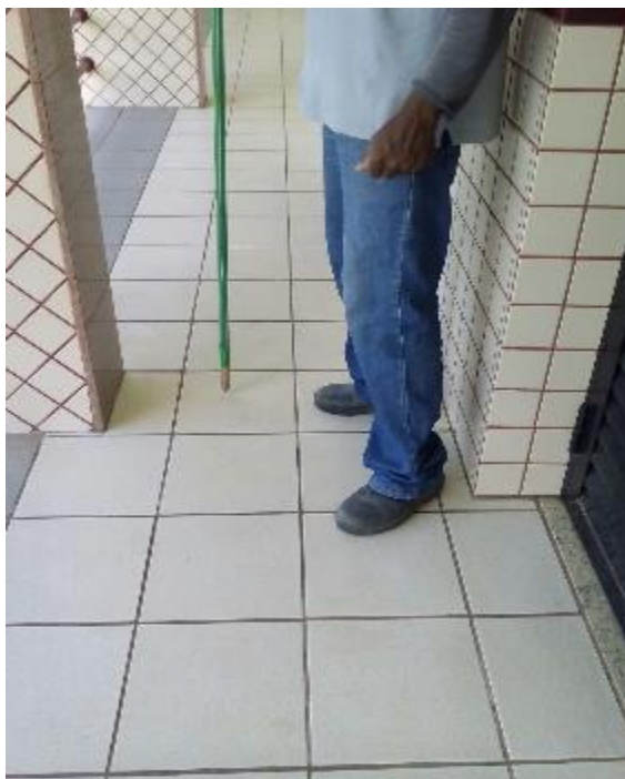
Figura 45 – Execução do ensaio de auscultação no piso do Pilotis.
