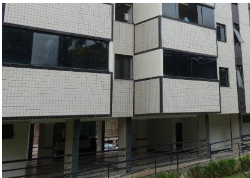
Figura 26 – Fachada Frontal do Edifício em análise (Vista do Pilotis).
