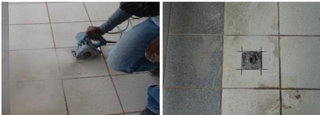
Figura 48 - Corte do revestimento cerâmico com equipamento adequado
