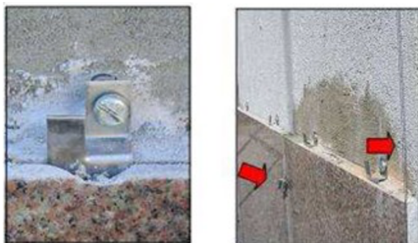
Figura 10 - Sistema Convencional para fixação de Granito, com auxílio de dispositivo G-fix.
