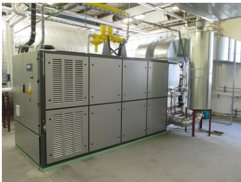
Obr. 46 Kogenerační jednotka Viessmann Vitobloc 200 EM-199/263
